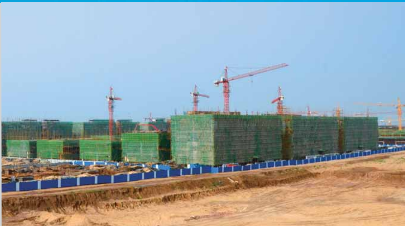
▲ CSC Zhengzhou under construction 在建中的鄭州華南城
