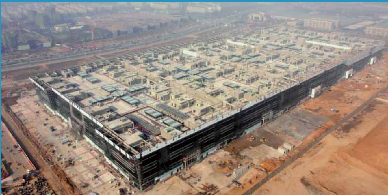
CSC Zhengzhou under construction 在建中的鄭州華南城
