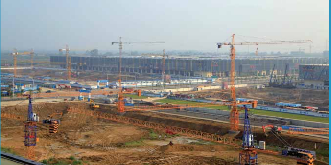
CSC Hefei under construction 在建中的合肥華南城
