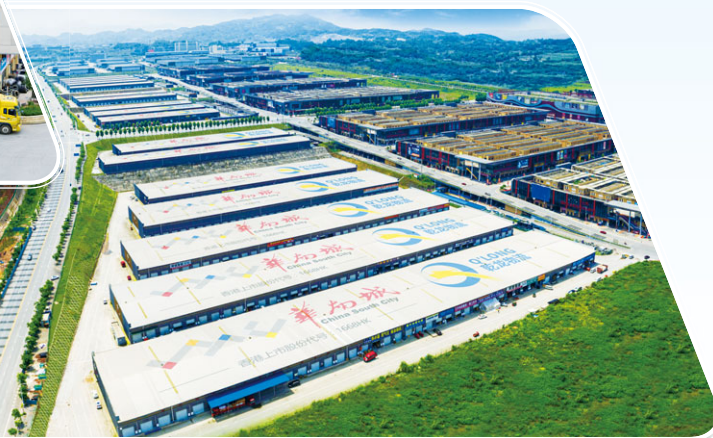
Qianlong Logistics Park in CSC Chongqing 重慶華南城的乾龍物流園區
