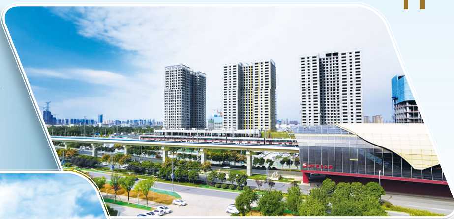
Xi'an Metro (Guoji Gangwuqu Station) 西安地鐵站(國際港務區站)
